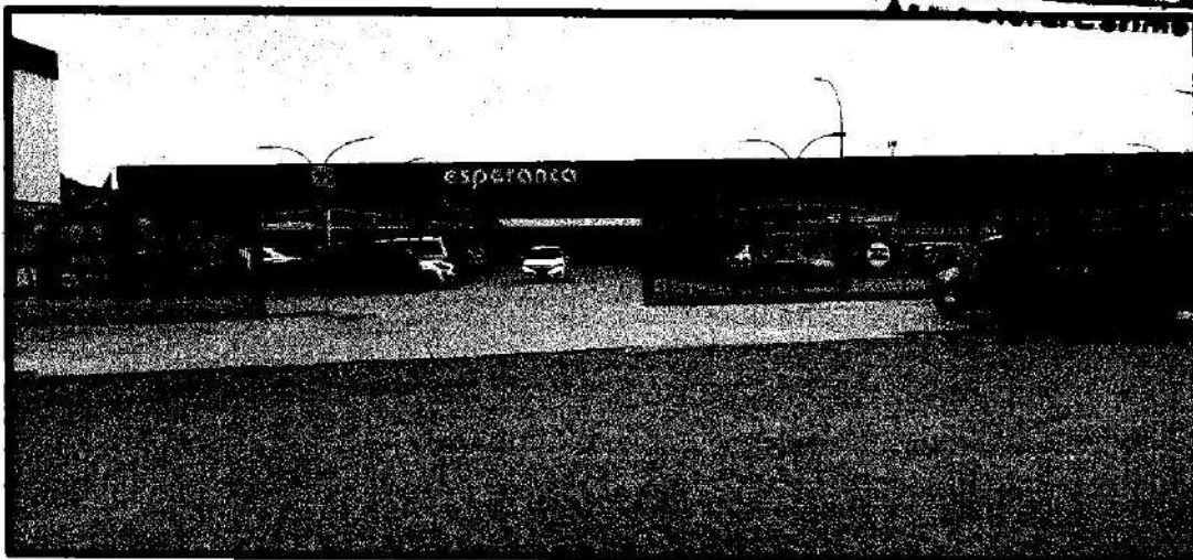
Foto 7 – Supermercado Esperança local de instalação dos sombrites e lajotas de concreto
